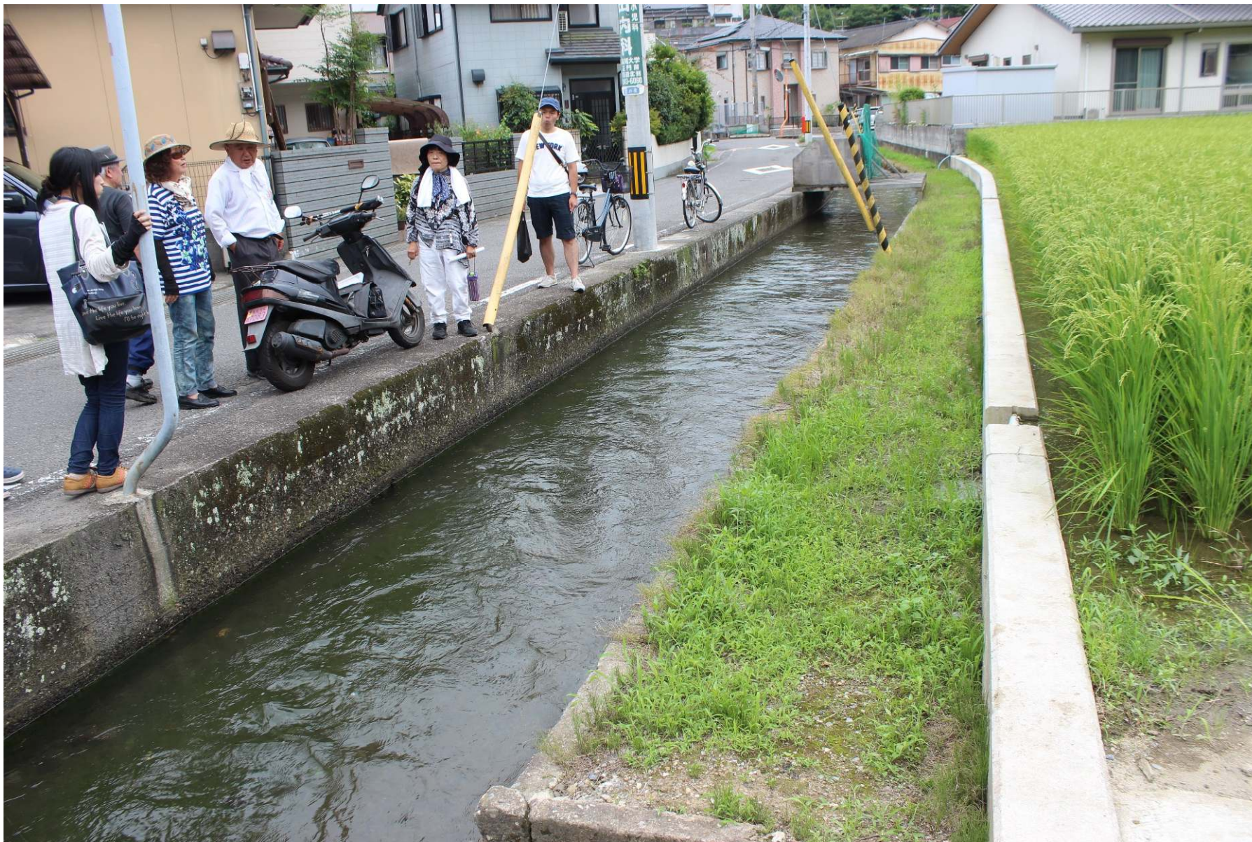
地域住民との朝倉水路歩き (水路の魅力と危険箇所のチェック)
