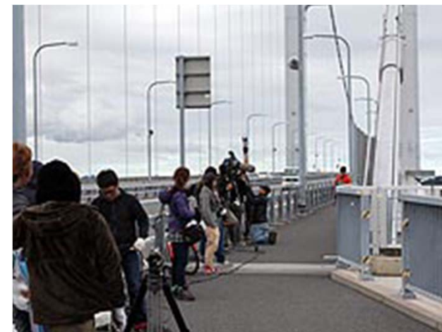
来島海峡大橋
