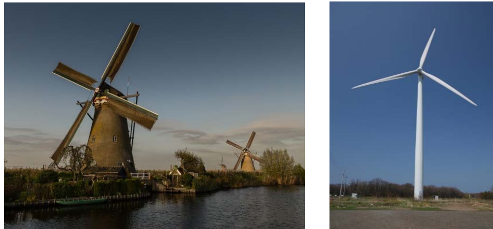
図3. （左）伝統的風車（オランダ型），（右）風力発電用風車（プロペラ型）
